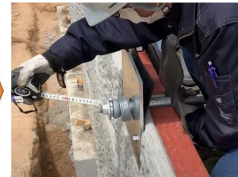
⑤ 診断用補強材（ロッド）の設置、仮締め
