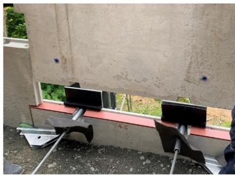
⑦ 上側壁面材の設置、固定 ⑧ 撒き出し、敷均し、締固め
