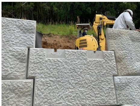
① 下側壁面材の設置
