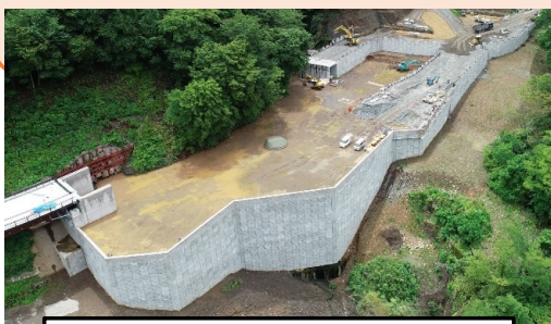
UAVによる点検の適用事例
